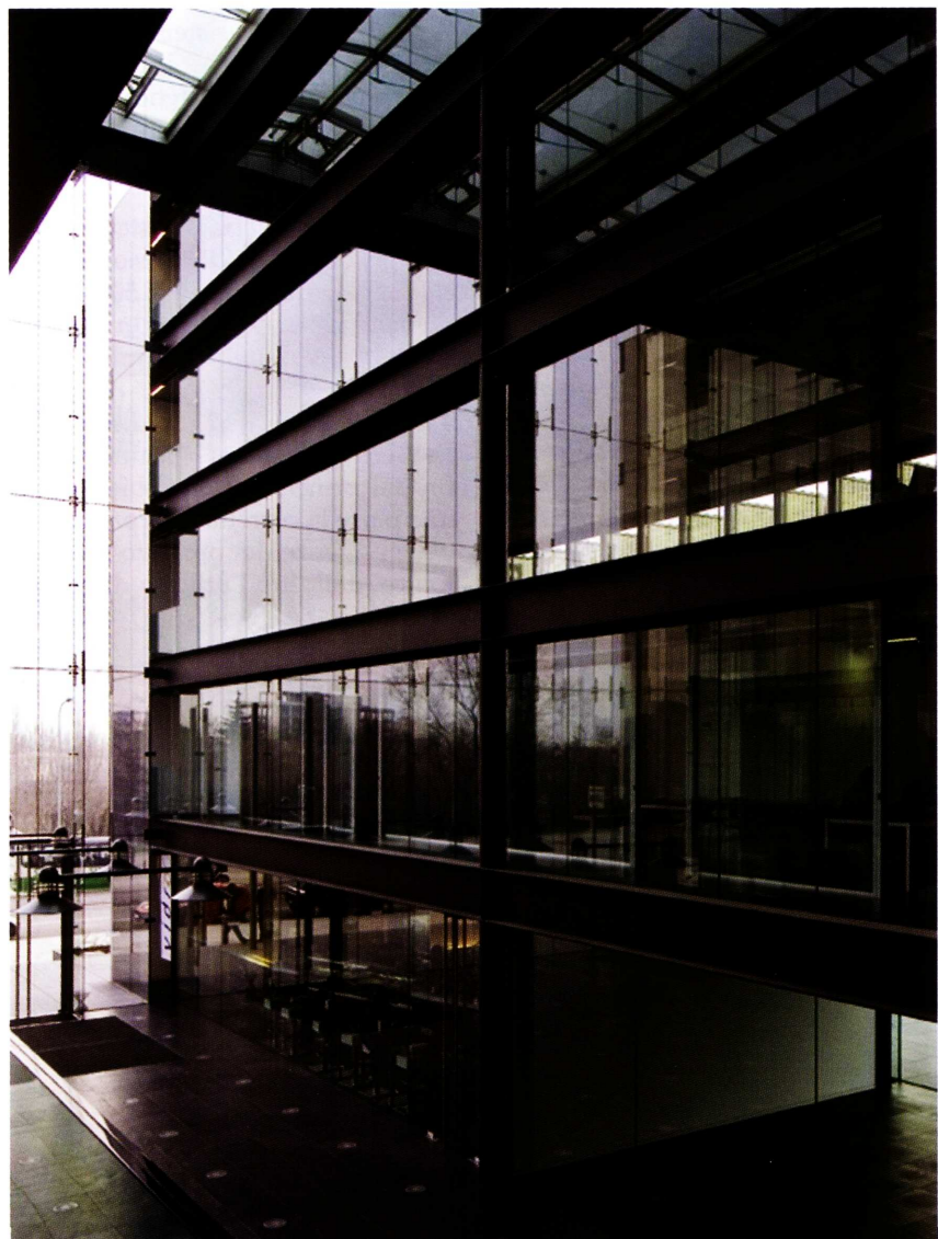
Fig. 13 - Interno del palazzo Tendenza e della facciata vetrata
