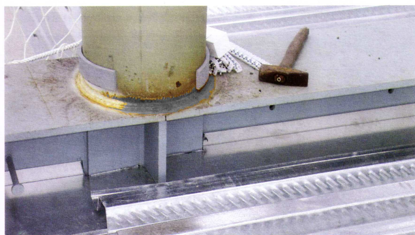
Fig. 7 - Dettaglio della saldatura tra tronchi di colonna e travi principali
