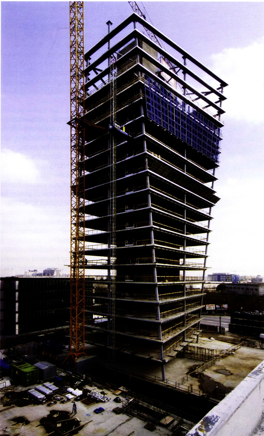
Fig. 28 - La torre a strutture ultimate
