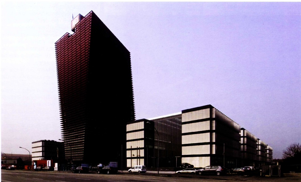
Fig. 1 - Vista generale dell'intervento
