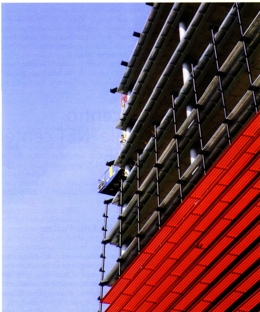
Fig. 2 - Particolare delle schermature frangisole dell'edificio a torre
