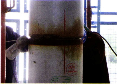
Fig. 25 - Saldature sulle colonne portanti
