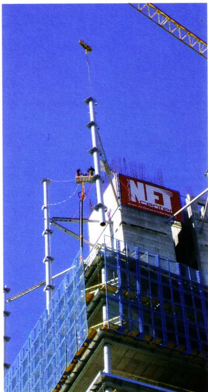
Fig. 22 - Fase di posizionamento delle colonne, con stralli provvisori
