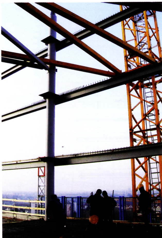
Fig. 23 - Fase di giunzione travi - colonne
