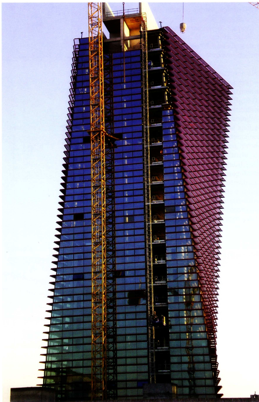
Fig. 19 - Particolare degli aggetti dell'edificio a torre
