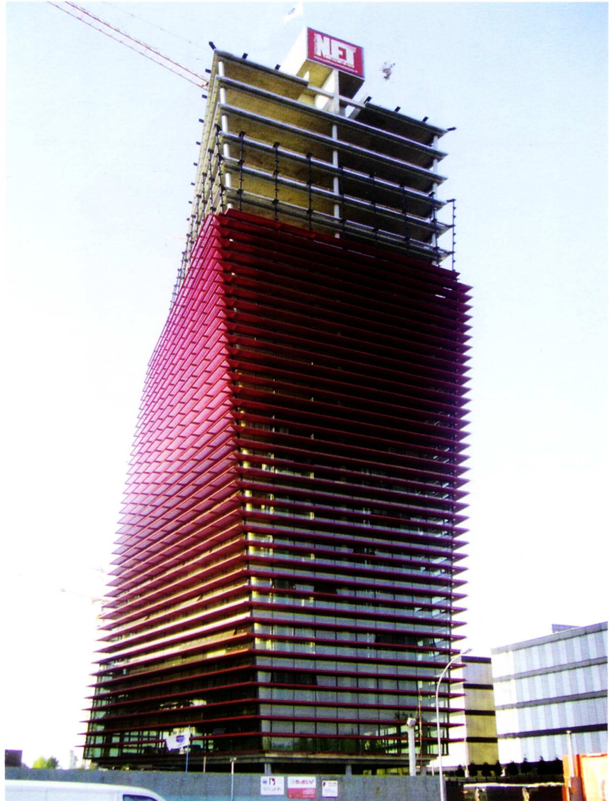
Fig. 16 - Elevazione della struttura metallica portante della torre
